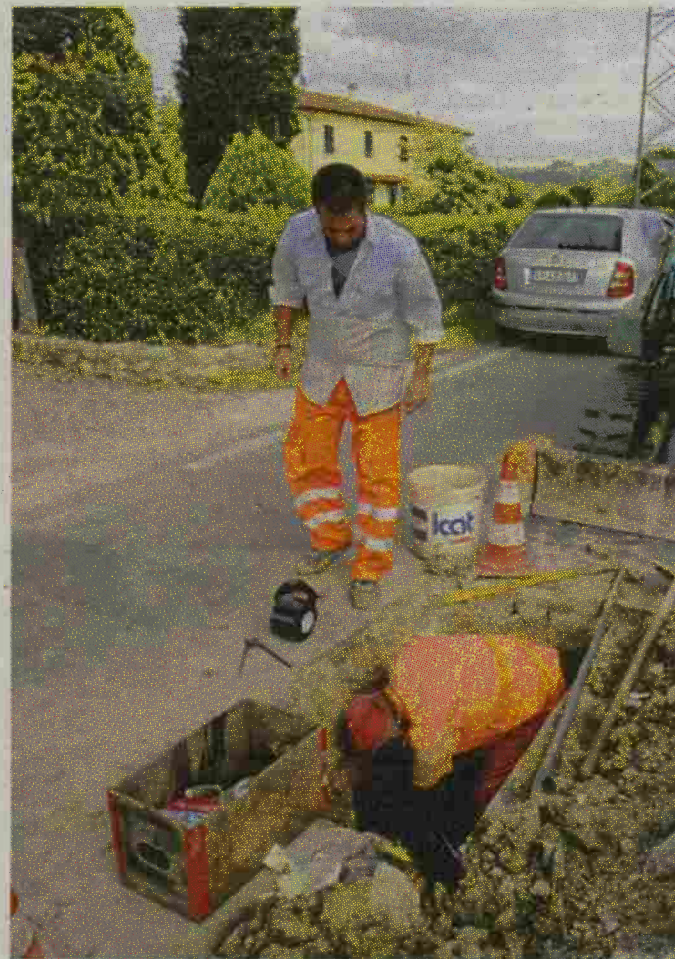
Lavori per l'estensione della rete del metano
