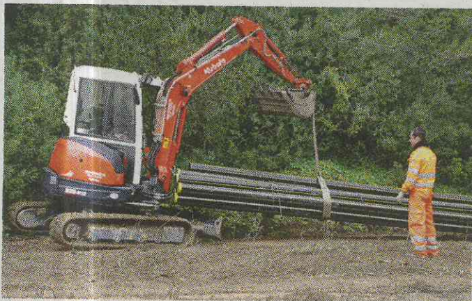
Lavori per l'estensione della rete del metano
